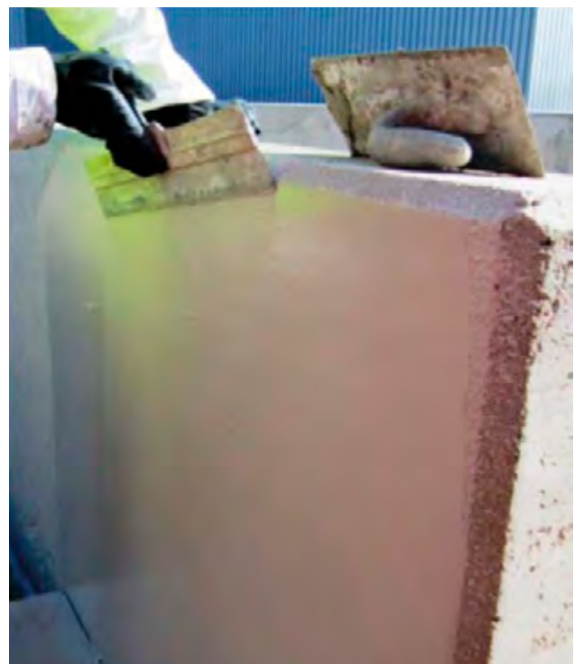
Rys. 3: Wykończenie MasterSeal 6100 FX
