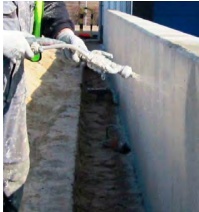
Rys. 2: Aplikacja natryskowa MasterSeal 6100 FX
